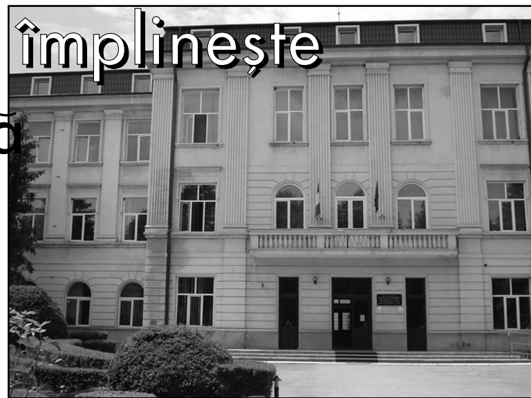
Fațada universității a fost complet remodelată, lucrările fiind terminate anul trecut
